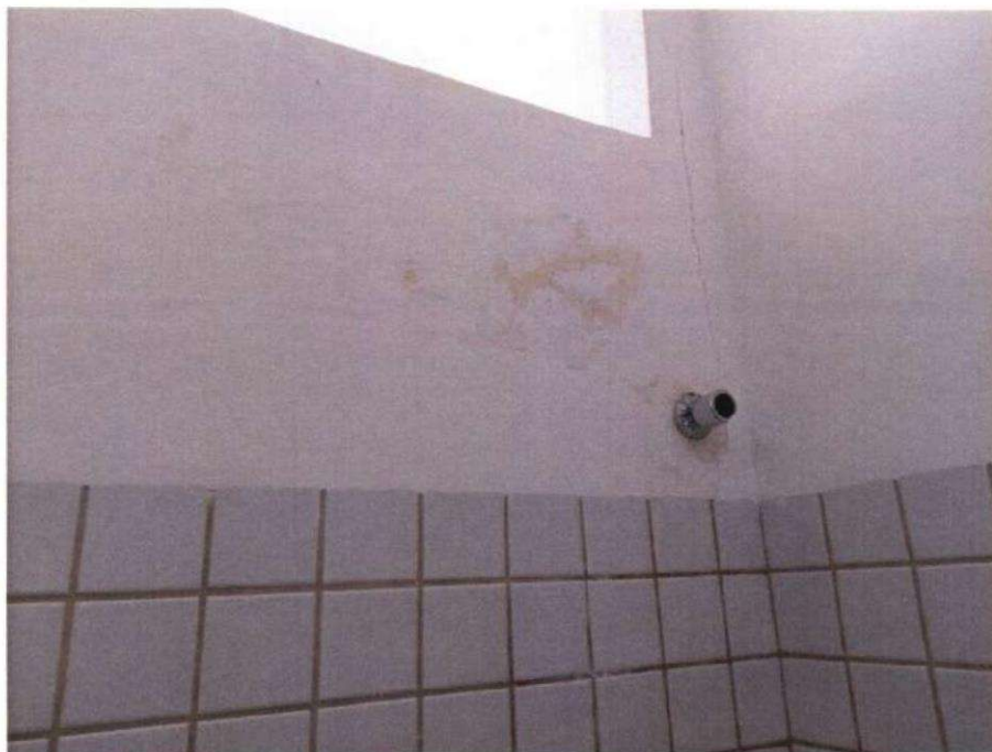
Foto 07: Detalhe da cerâmica a ser retirada para verificação de possível vazamento na tubulação;
