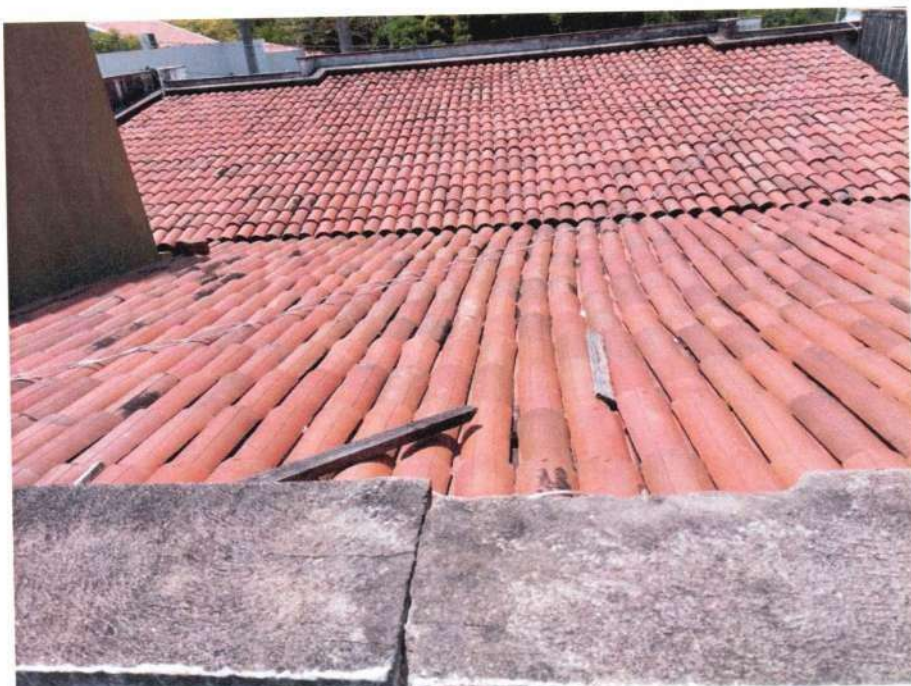
Foto 06: Detalhe da cobertura de telha cerâmica;
