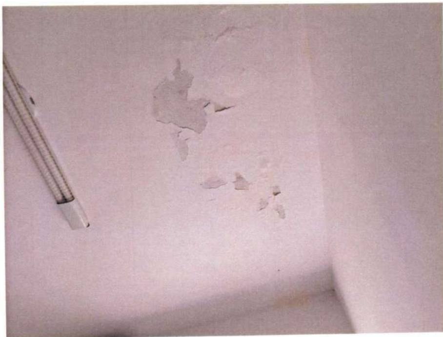
Foto 05: Detalhe da umidade no teto;
