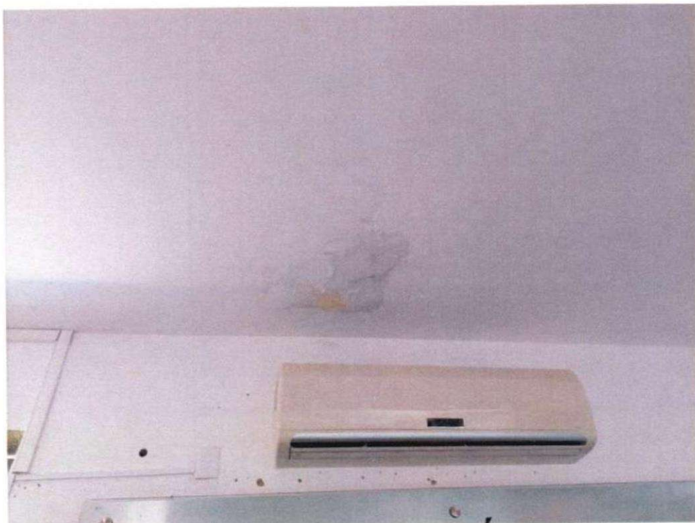
Foto 04: Detalhe da umidade no teto;
