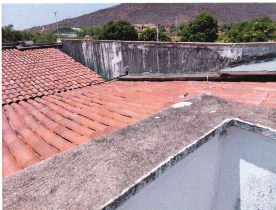
Foto 15: Detalhe da calha a ser impermeabilizada;
